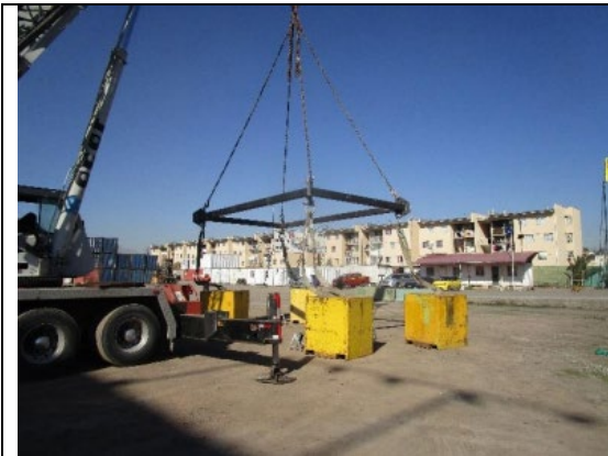
Ganchos de Carga Indirecta la cual trabaja fuera de la vertical
